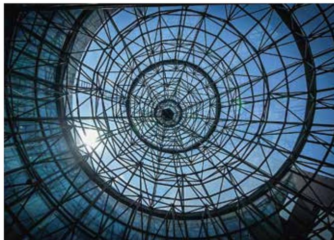
и выгодно организовать внутреннее пространство здания, не загромождая полезную площадь и световой фронт бетонными колоннами. Кроме того, технология востребована в районах с сильной сейсмической активностью.
