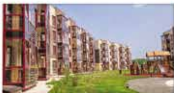
МЖК «Бавария» Новосибирская область, г.п. Красныйоб, ул. Мавролайск. №7, дома 1-14 | www.bavaria54.ru ООО «АКД»
