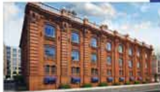
WineHouse Москва, ул. Садовническая, вл. 57 Галс-Девелопмент
