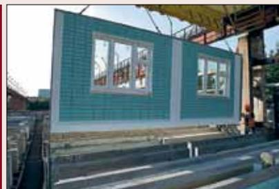
кий коэффициент сопротивления теплопередаче. Кроме того, ширина данного профиля — 127 мм — идеально подходит для панельного домостроения. Отдел технического контроля «ПИК-Профиль» ведет сквозной контроль качества оконных блоков, а специалисты ДСК-2 отслеживают качество монтажа ПВХ-конструкции в железобетонную внешнюю панель. Только после этого готовая деталь отправляется на стройку.
